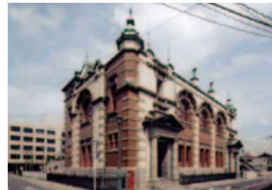
旧唐津銀行本店 (元・設計施工、改修施工)
