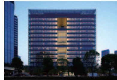
豊洲キュービックガーデン(設計・施工)
