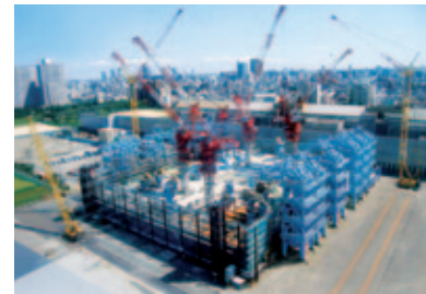
東尾久浄化センター主ポンプ棟建設工事
